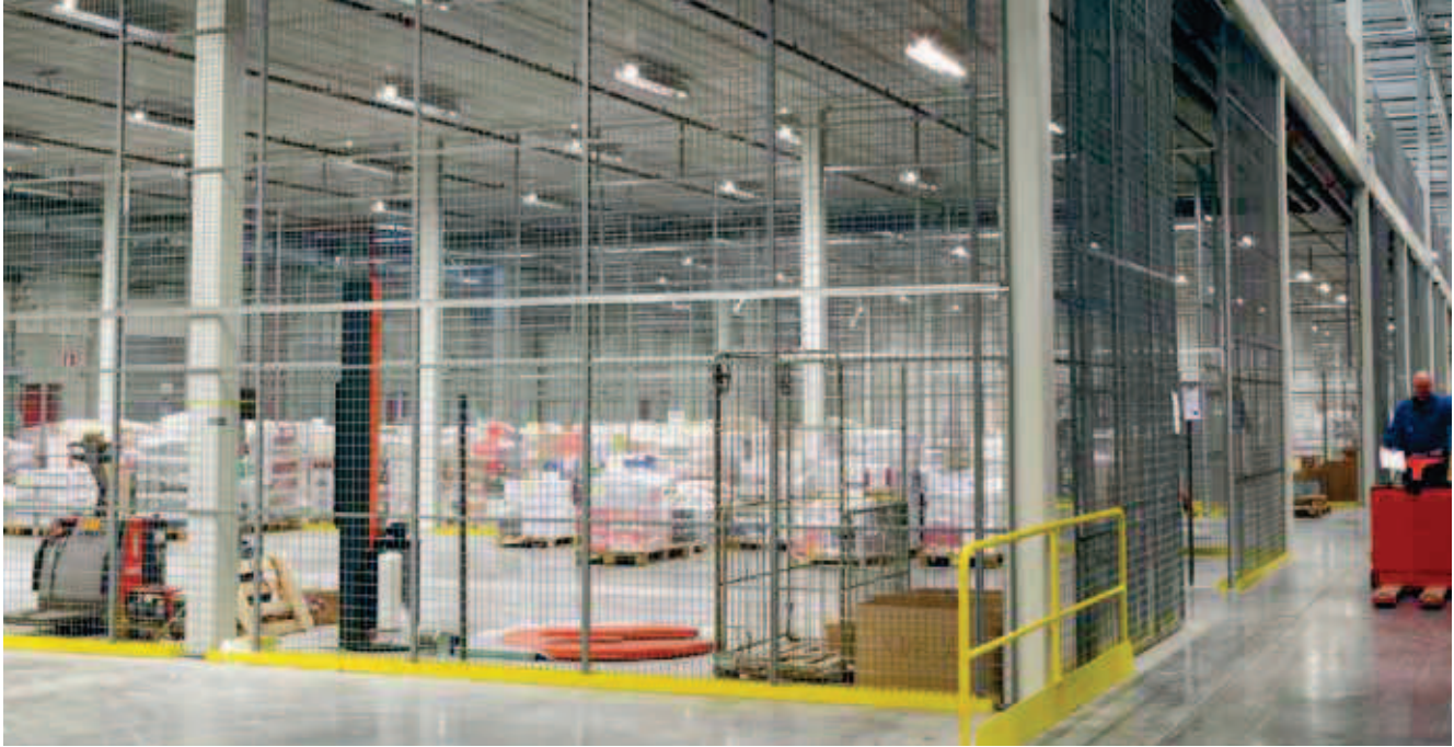
Local de stockage protégé.
